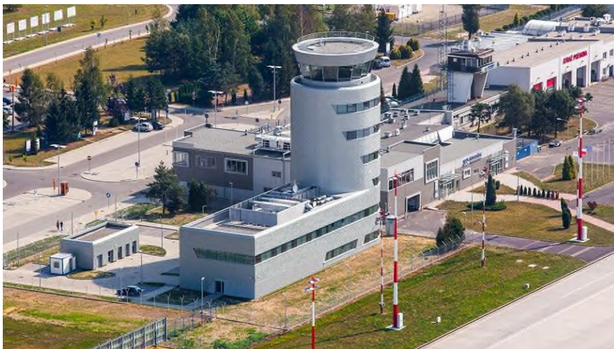
Zdj. nr 1 Wieża Kontroli Ruchu Lotniczego
