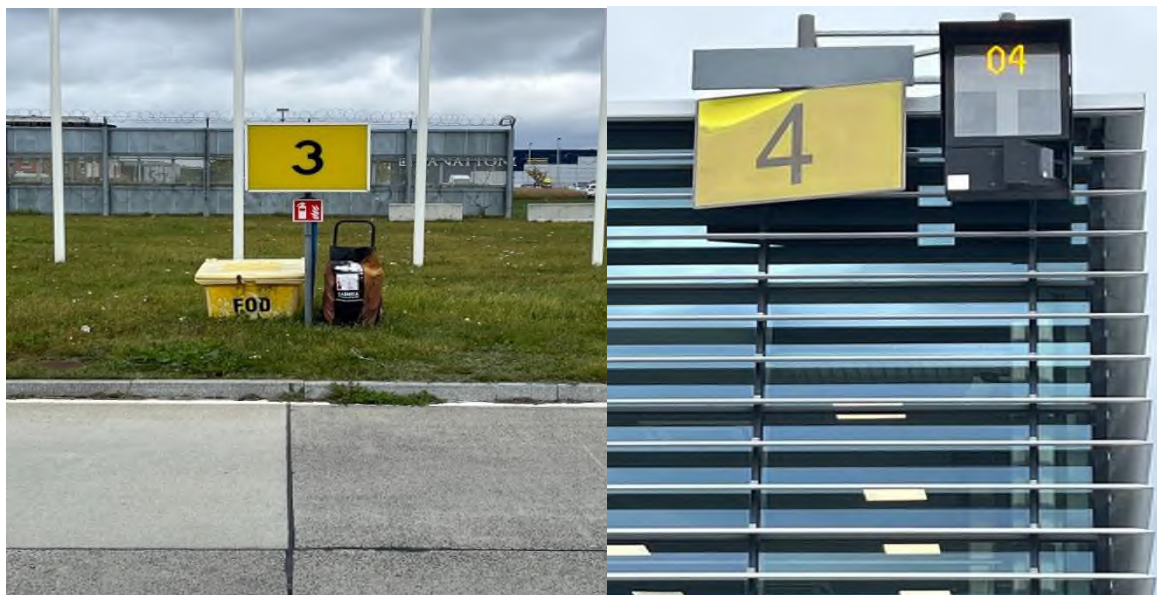
Oznakowanie pionowe stanowiska nr 3 i znak pionowy wraz z systemem dokowania – stanowisko nr 4
